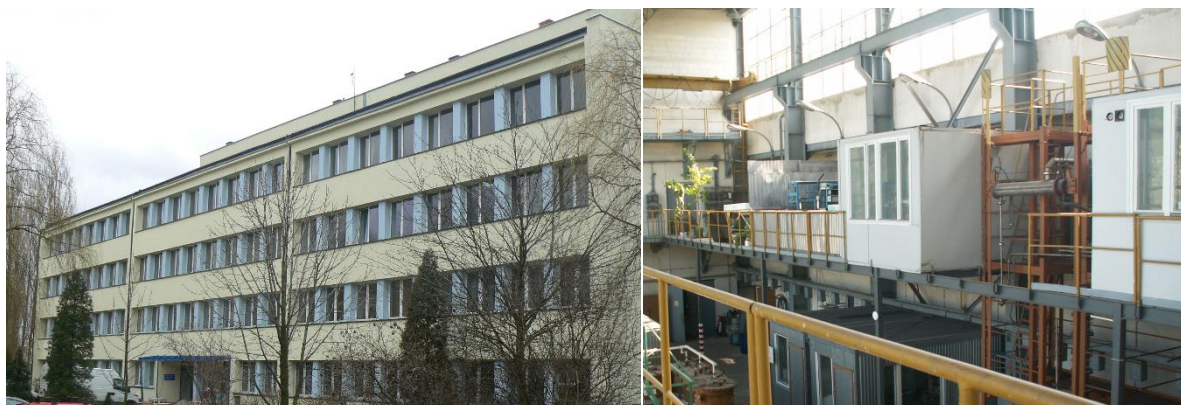
Rys. 2. Budynek Instytutu przy ul. Bałtyckiej 5 w Gliwicach (po lewej); po prawej fragment hali technologicznej.
